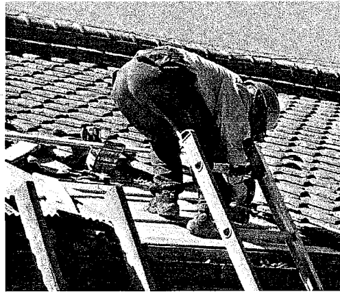
新会館 屋根修理
