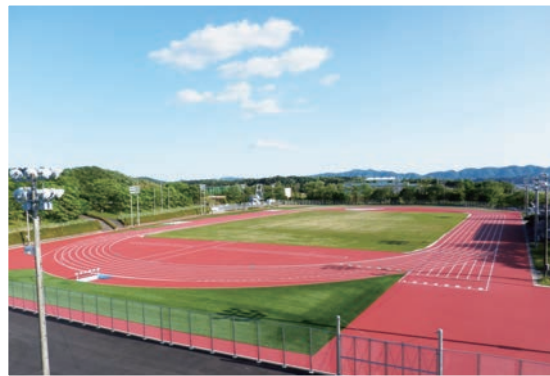
▲中池公園陸上競技場完成（5月）
