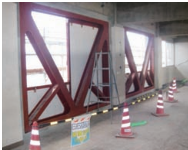
耐震補強工事（ブレース設置）
