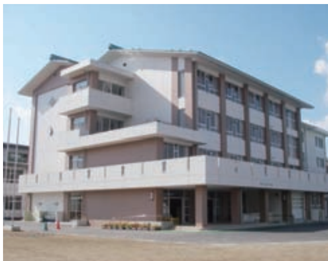
改築工事 金竜小学校（北舎）
