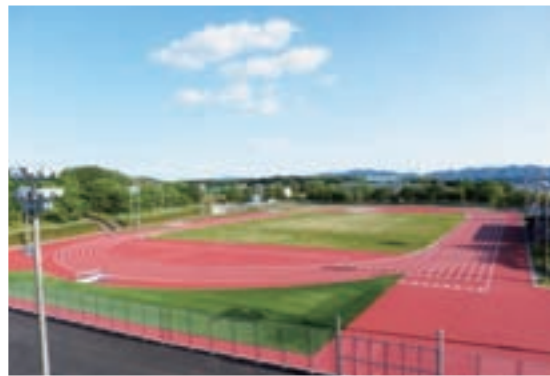
▲中池公園陸上競技場完成（5月）
