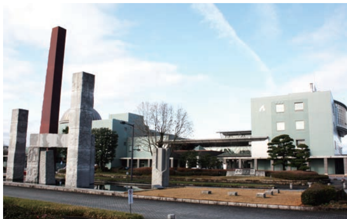
▲わかくさ・プラザの建設費は約109億円。 いつかは更新時期を迎えることに…
