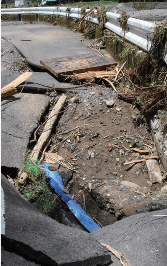
▼ めくれた道路のアスファルト（上之保）
