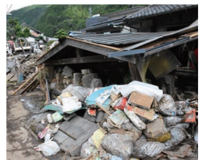
▲ 倒壊した家屋（上之保）
