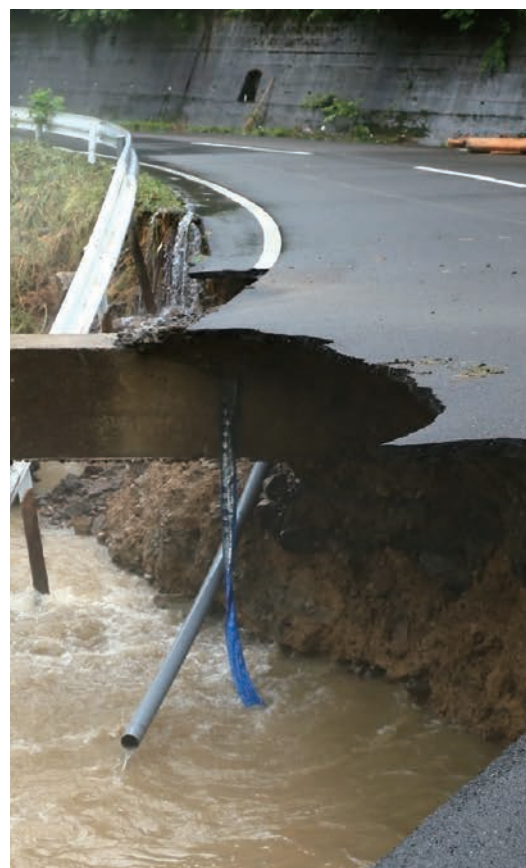
▼ 崩落した道路（上之保）
