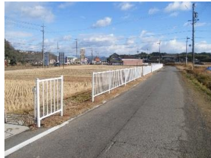
転落防止柵設置
