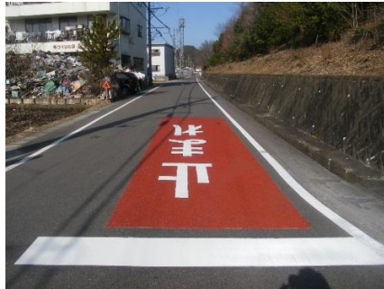
車道カラー舗装
