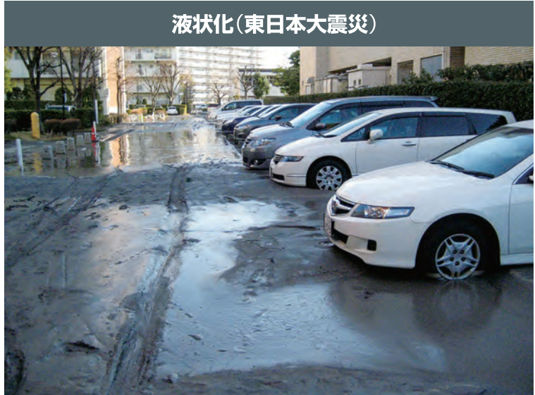
液状化(東日本大震災) 提供元：千葉県浦安市富岡工ステート住宅管理組合自主防災隊 出 典：地震本部ウェブサイト https://www.jishin.go.jp/
