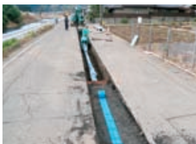
▲水道管(耐震管)の布設工事(富之保地内)
