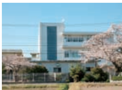
▲手前が旧電気発電機棟、奥が新電気発電機棟(3階建て)
