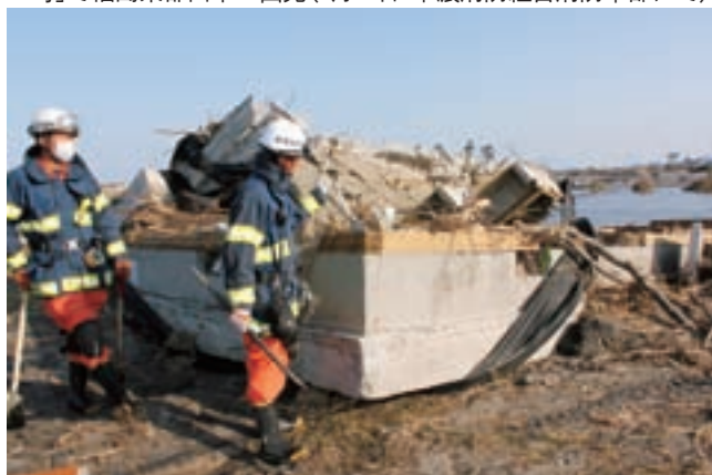
▲福島県新地町での救助活動・津波により住宅の建物は全壊し、基礎も押し流された (3 月 11 日～14 日)【中濃消防組合提供】
