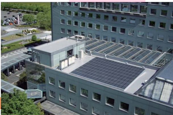
▲市役所庁舎に太陽光発電システム設置(5月)
