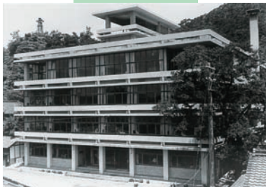
▲鉄筋4階建の市庁舎が完成 =昭和34年
