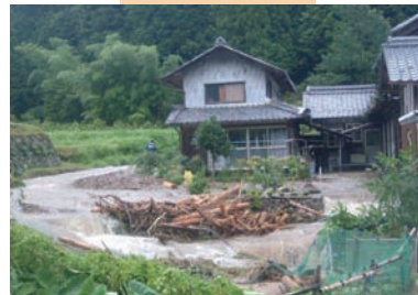
▲武儀集中豪雨災害発生＝平成21年
