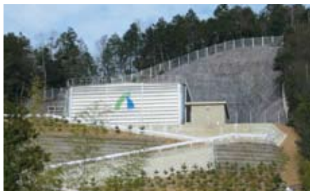
高井坪配水池
