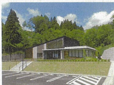
視察先：災害資料伝承館(旧田老町役場跡)
