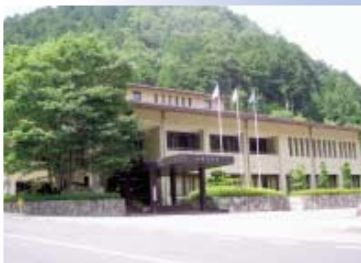
関市板取事務所
