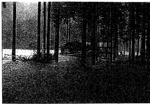
平成14年台風第6号 関市洞戸尾倉付近
