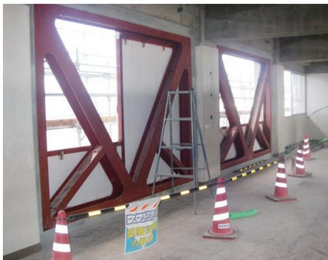
耐震補強工事（ブレース設置）
