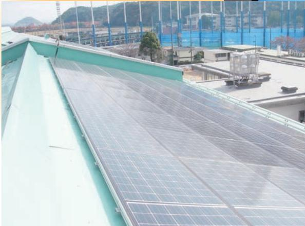
校舎屋根に設置した太陽光パネル
