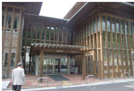
かみのほ生涯学習センター
