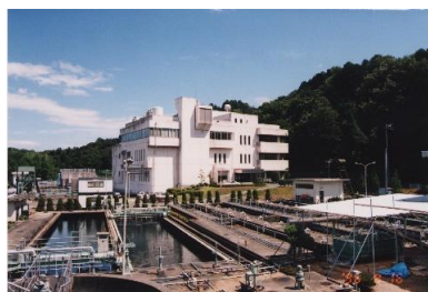
浄化センター 管理棟(昭和56年完成)
