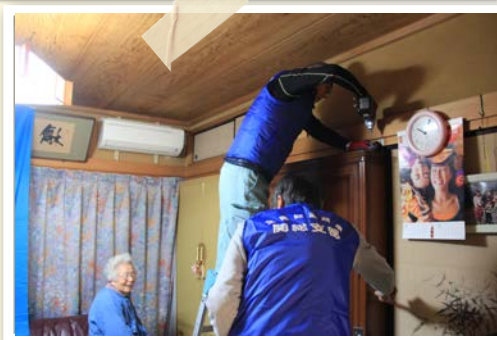
タンスはL字金具で柱に固定
