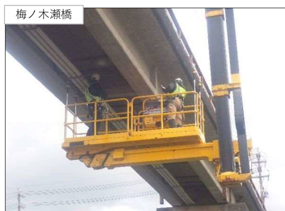
近接目視による点検状況（橋梁点検車）
