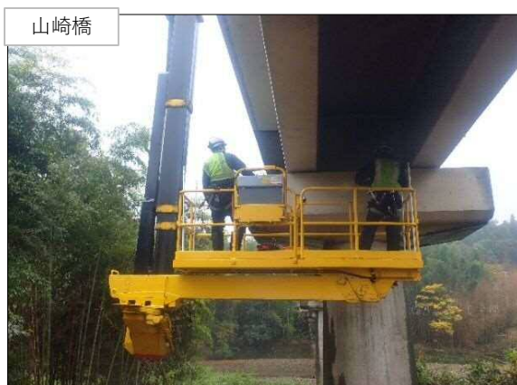
近接目視による点検状況（橋梁点検車）
