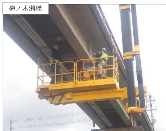
近接目視による点検状況（橋梁点検車）
