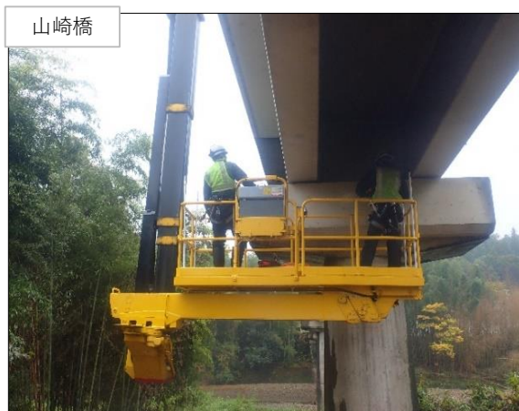
近接目視による点検状況（橋梁点検車）
