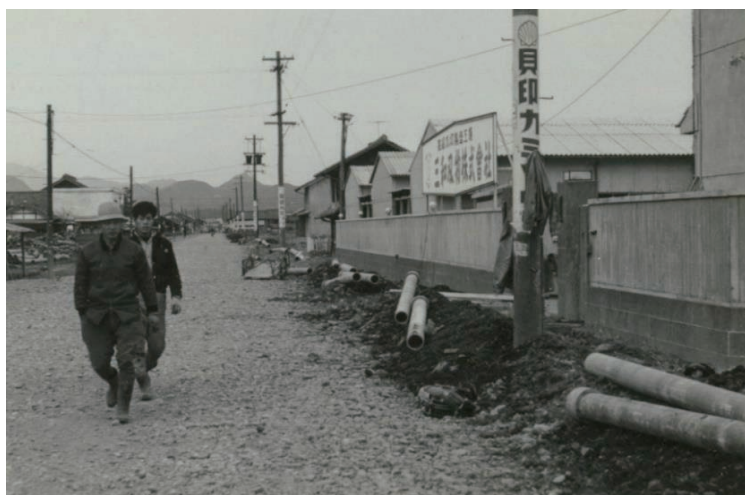
昭和30年代 水道管配管工事
