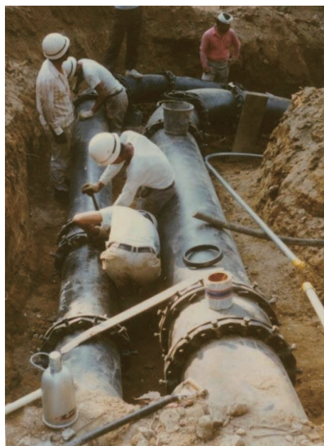
昭和54年 山田配水池配管工事
