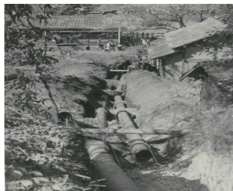
昭和28年頃 安桜山配水池
