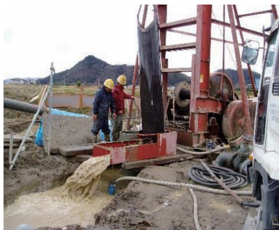
井戸掘削 (東志摩水源地)
