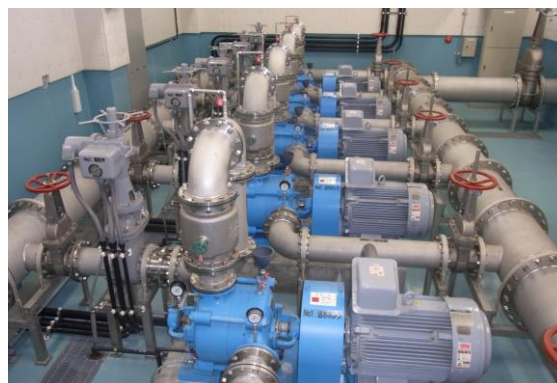
小瀬水源地 送水ポンプ
