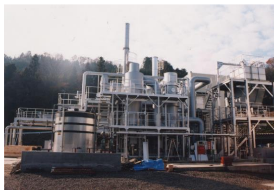
関市浄化センター 汚泥焼却炉
