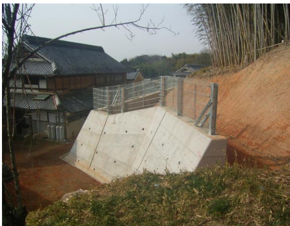
塔ノ洞地内 急傾斜地崩壊対策事業
