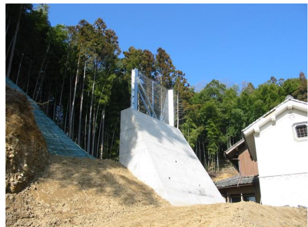
下之保地内 落石防護柵
