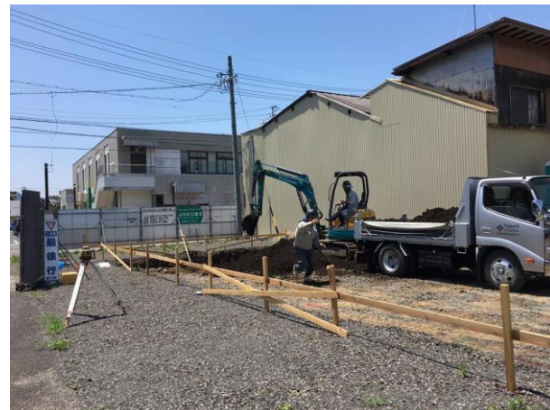
▲基礎工事のための掘削が始まりました！（撮影：6/16）
