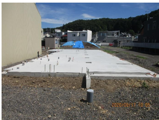
▲基礎コンクリート完成（8/17撮影）
