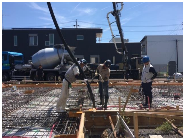
▲コンクリートの打設を行いました。（8/1撮影）
