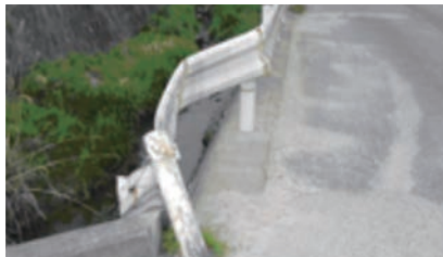
ガードレール破損
