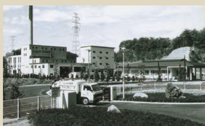
平成元年、中濃広域清掃センターに粗大ごみ 処理施設が完成する
