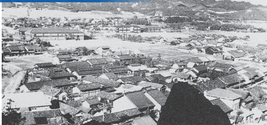
昭和 25 年の市街地東部の風景 (写真中央が旭ヶ丘中学校、左が旭ヶ丘小学校)
