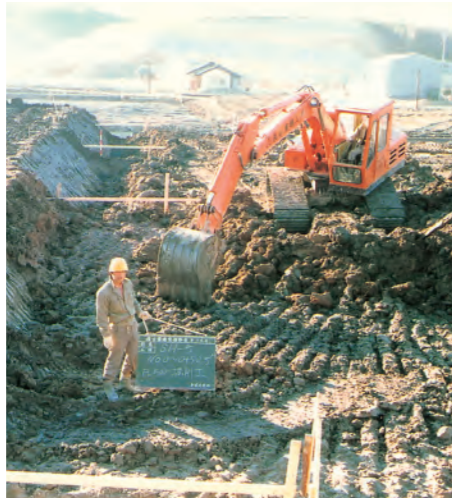
昭和52年、稲口の土地改良工事着工。
