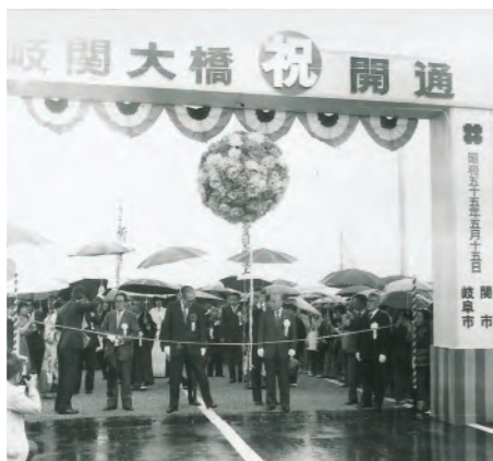
昭和55年、岐関大橋が開通しました。
