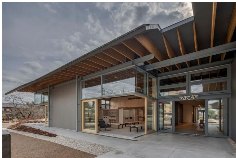
関市地域交流施設せきてらす
