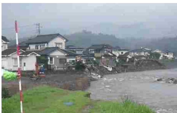
河岸侵食による家屋の倒壊(花月川)
