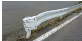
ガードレール破損
