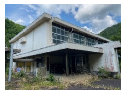
改修前の体育館
