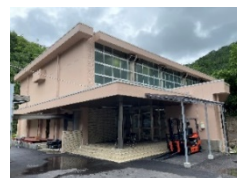
改修後の体育館
