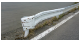
ガードレール破損
