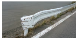
ガードレール破損
