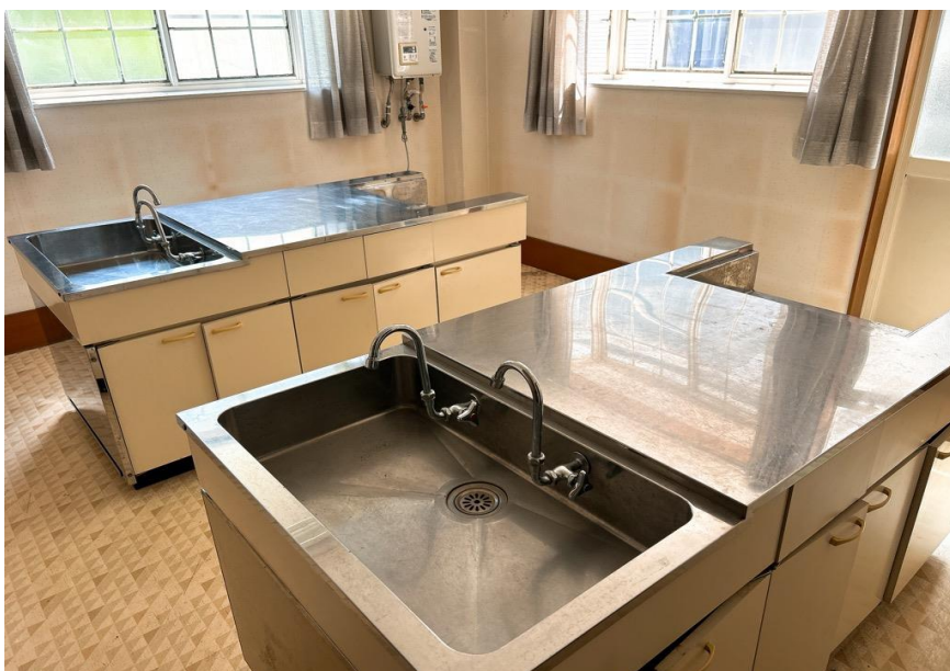
⑤集会所(津保公民センター) 調理室
