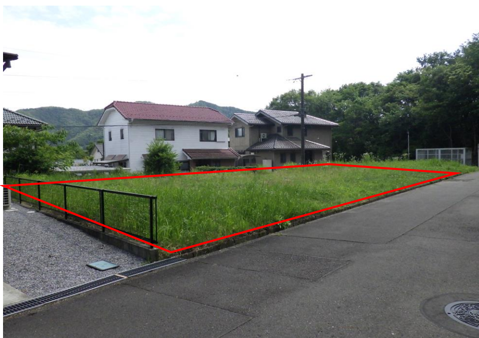
②北東方向から
