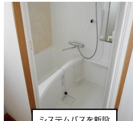
システムバスを新設
