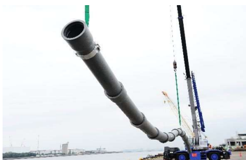
画像提供：日本ダクタイル鉄管協会
