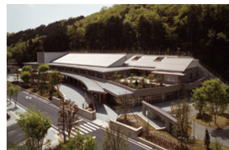
総合斎苑わかくさ空調更新工事
