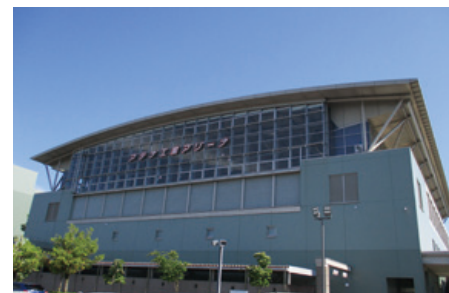
アテナ工業アリーナ 大規模改修
