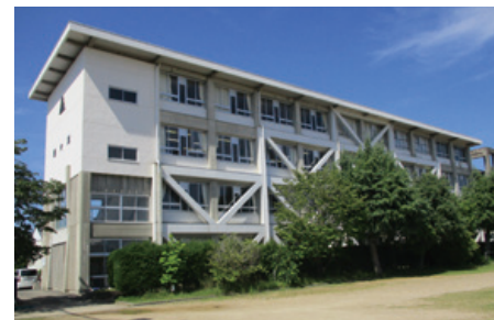
旭ヶ丘中学校長寿命化改良
