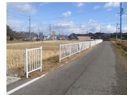
安全対策実施箇所の例(柵の設置)
