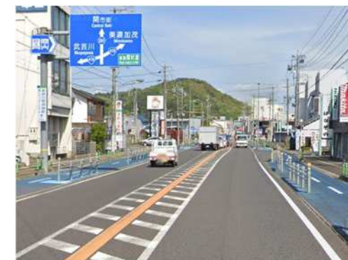
県道 関本巣線の自転車道
