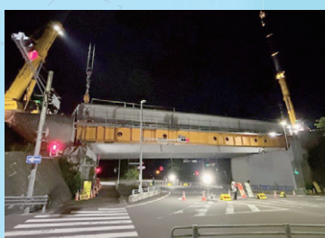
夜間に行われた橋桁の架設
