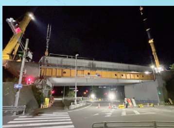
夜間に行われた橋桁の架設
